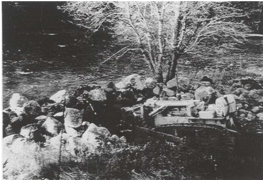
Placing stone fill or rip-rap.
