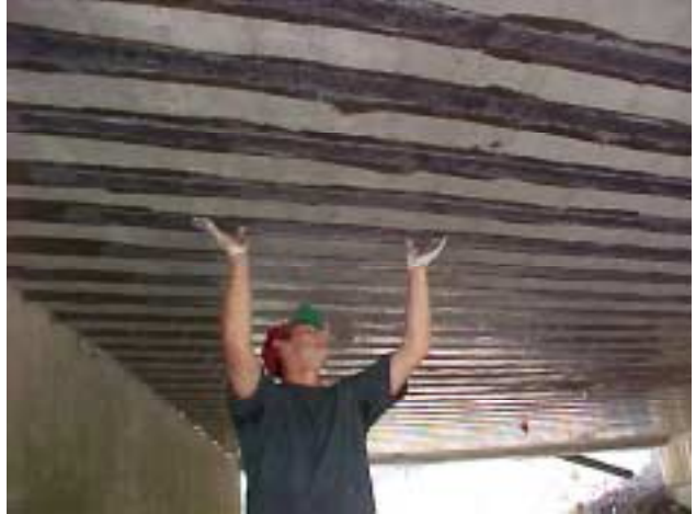
(d) Installation of FRP plates
