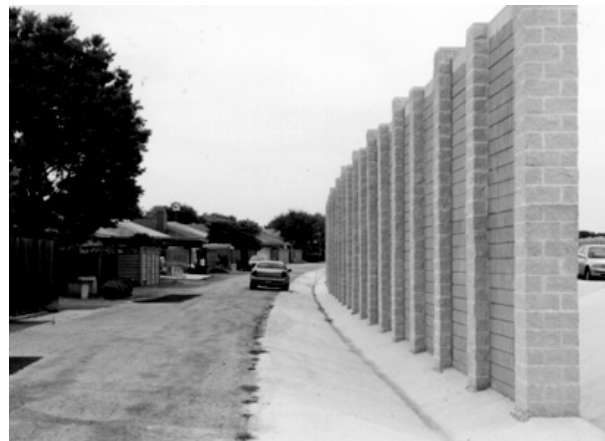
(d) End of noise barrier at Webster Drive
