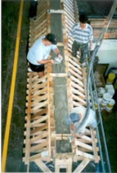
Figure A-7: Typical beam pour
